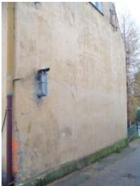
Fot.4 Widoczny stan techniczny konstrukcja zagrożonej – wyboczonej - ściany szczytowej od zewnątrz budynku.
